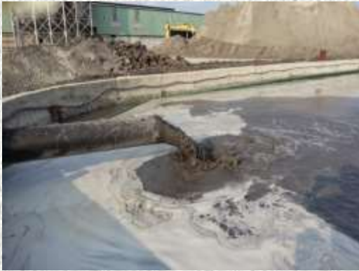
1. Bể chứa tro xỉ cấp từ Nhà máy nhiệt điện ra
