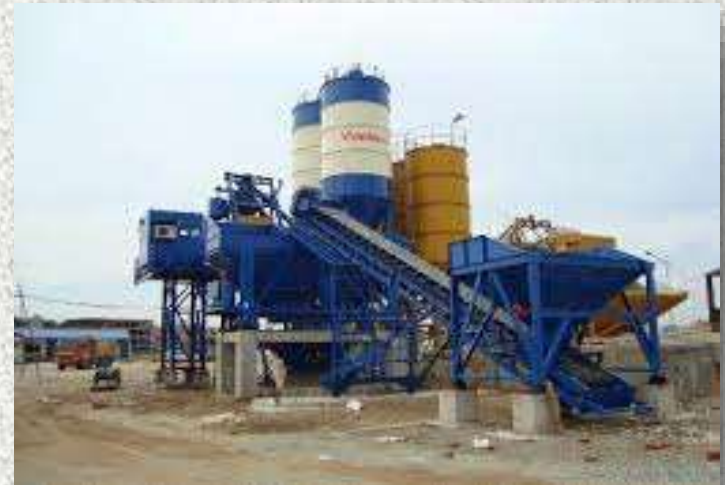
6. Trạm trộn bê tông
