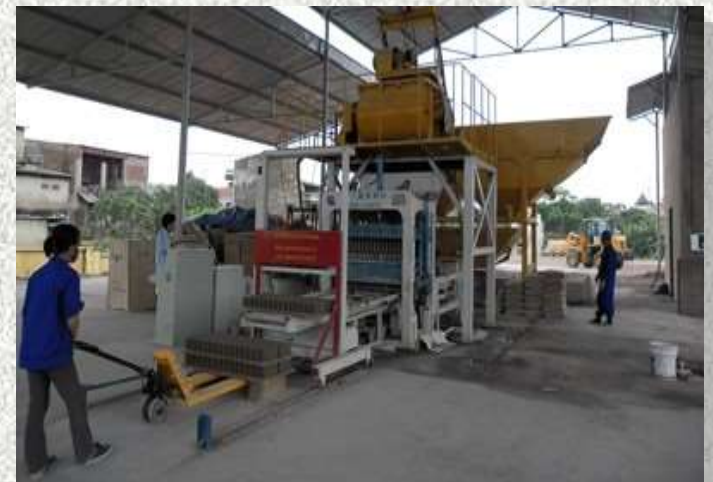
8. Nhà máy gạch cốt liệu
